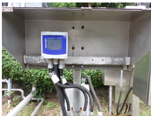
ภาพที่ 2-5 ระบบควบคุมค่าความเป็นกรด-ด่าง, ความขุ่น, อุณหภูมิ และปริมาณของแข็งที่ละลายน้ำได้
