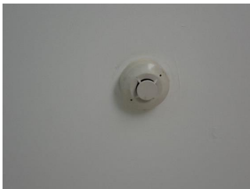
ภาพที่ 2-23 เครื่องตรวจจับควัน และความร้อน (Smoke / Heat Detector)
