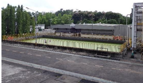
ภาพที่ 2-3 บ่อพักน้ำขนาด 4500 ลบ.ม.
