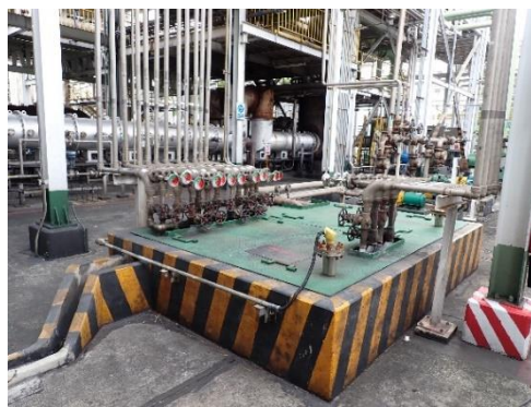
ภาพที่ 2-4 บ่อรวบรวมน้ำทิ้งจากการหล่อเย็นขนาด 12 ลบ.ม.
